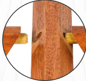
Petits bois extérieurs assemblés par tourillons et montés au cadrage de l'ouvrant.
