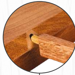
Petits bois extérieurs assemblés par tourillons et montés au cadrage de l'ouvrant.
